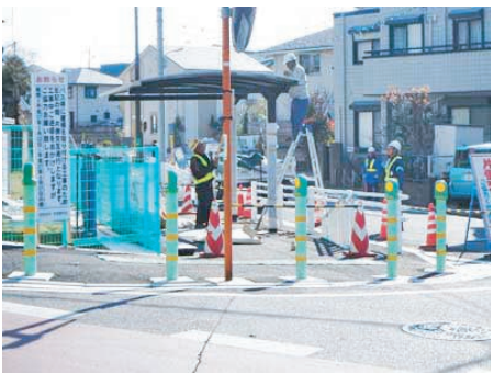
かつての湿地を埋め立てて歩道に整備し、 コミバスのバス停に屋根をつける工事中
