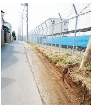
三山5丁目の自衛隊脇道 右側部分が未舗装。 砂利が敷かれた。
