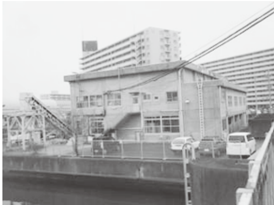
船橋排水機場・海老川水門
