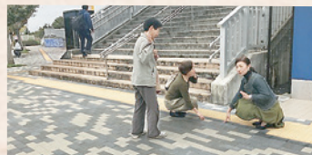
▲小室駅前広場のタイル貼り替え整備
